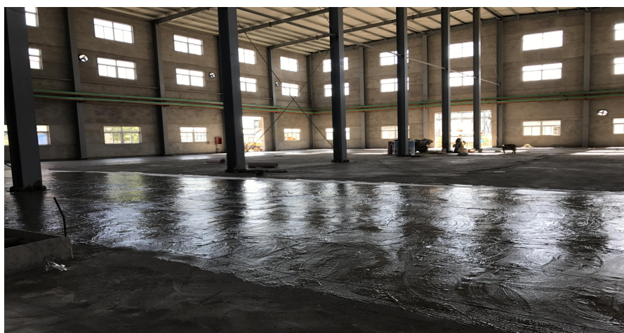
地下水防渗措施---聚乙烯丙纶复合防水材料防水施工过程
