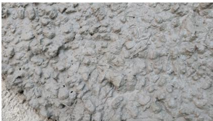
厂房周边地面采用钢纤维混凝土地面
